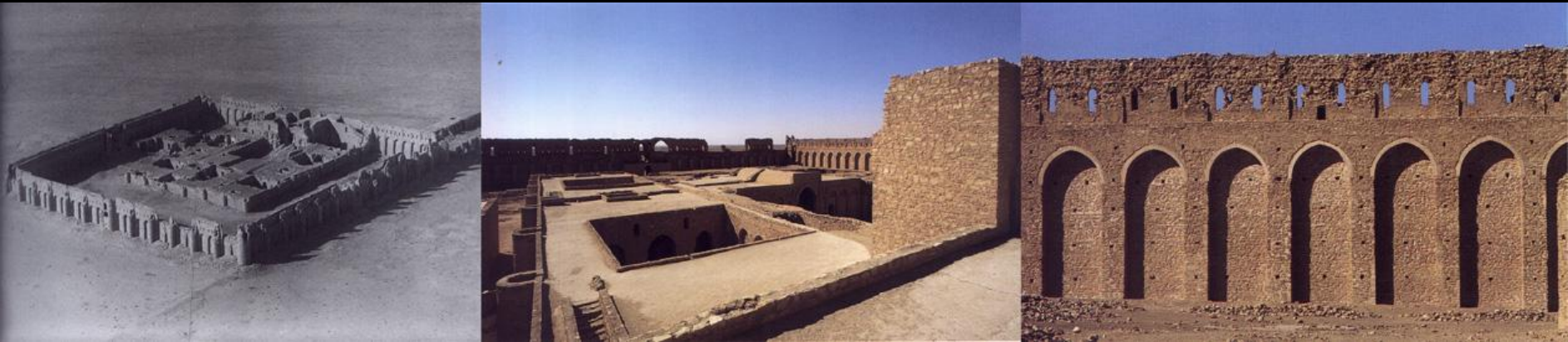
Esq.: Vista aérea do palácio de Ukhaïdir em Kufa. (775-6). Centro: Interior da muralha do palácio de Ukhaïdir. Dir.: Muralha interior, detalhe.
